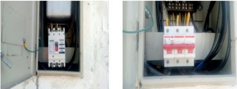
Suministro e instalación de cable eléctrico calibre N° 12 longitud 22m, e instalación de breaker de 20 A en tablero de distribución.
